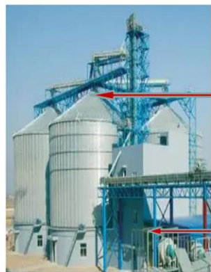
粮仓顶部粮食输送入仓气流杀菌装置
